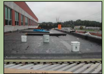
EPDM layer atop R-30, Aug. 2005
